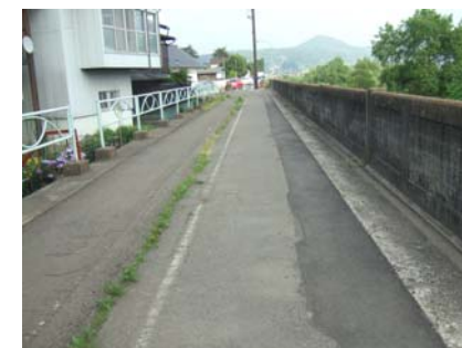
既設護岸(階段)堤防天端から御蔵方向(下流)
