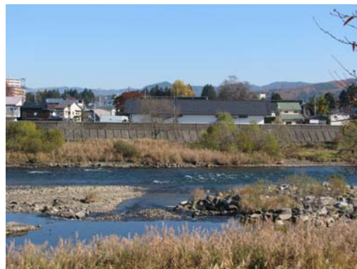
御蔵付近 対岸から望む(旧奥州街道:舟橋跡)
