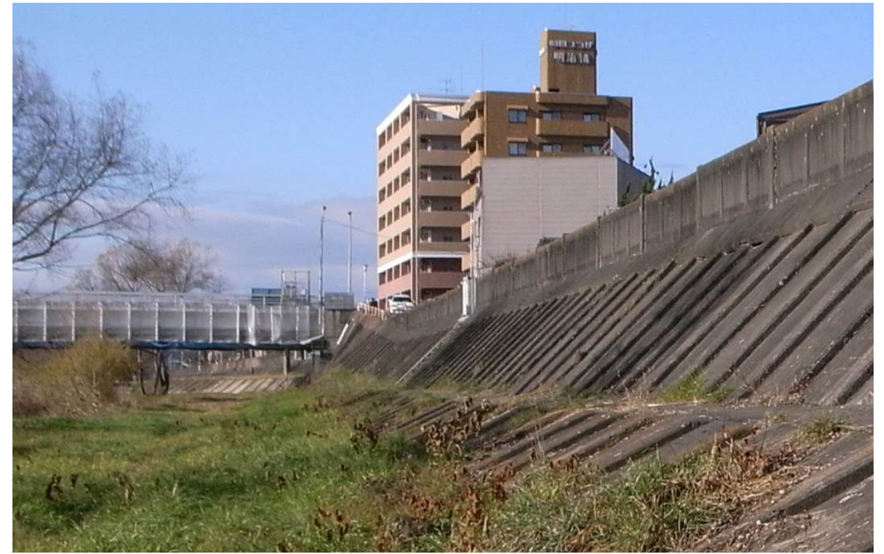
〈現況〉明治橋下流階段
