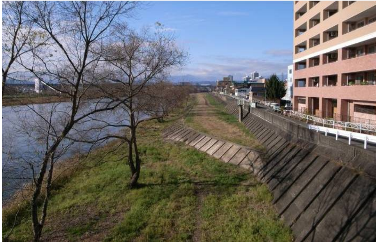
〈現況〉明治橋上流
