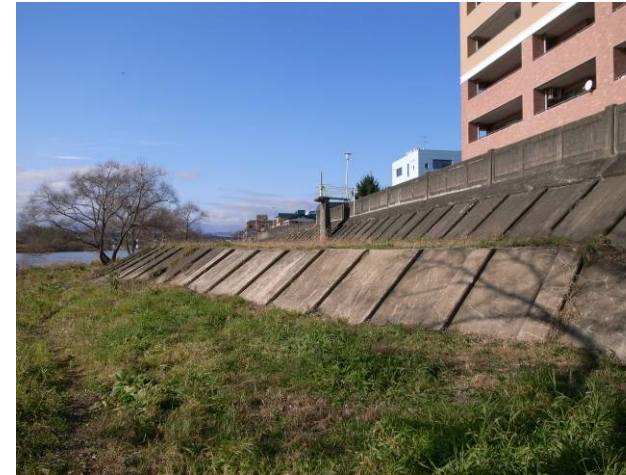
既設護岸の高低差は約1.5m(上流方向を望む)
