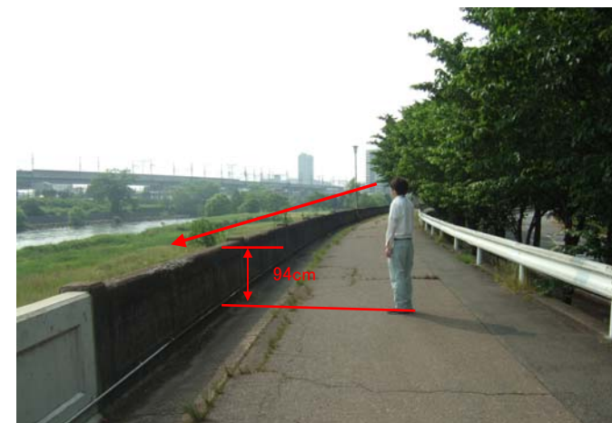
新設区間の天端状況 パラペット高 94cm 段差なし
