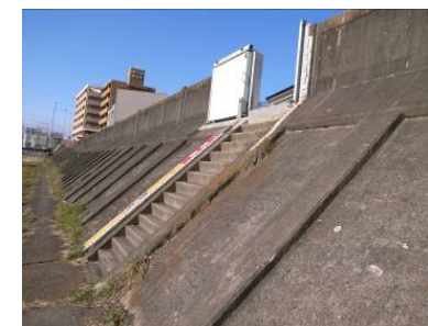
既設護岸(階段)の勾配は1:0.5(高低差約4m)
